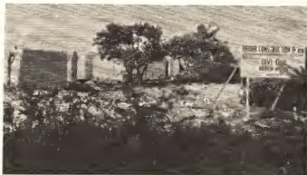
Otro Hotel turistica den construcion riba nos playanan na Aruba. Aki nos ta mira obreronan na trabao, den construcion di Divi-Divi Beach Hotel.
